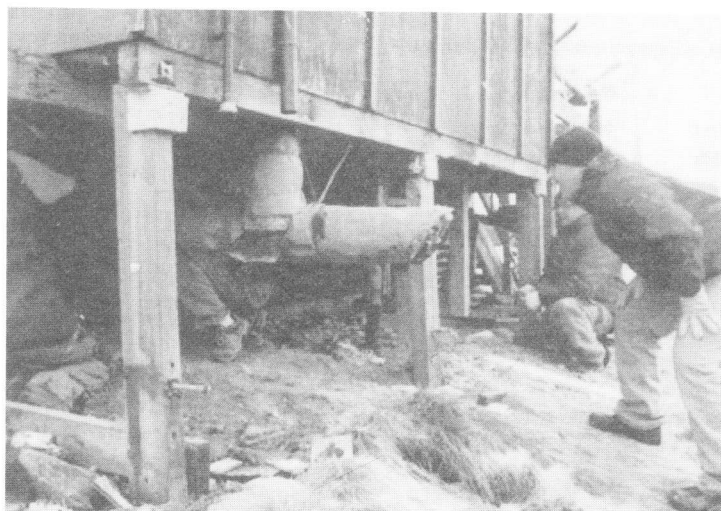
⑪ 傾いた家屋の修復
